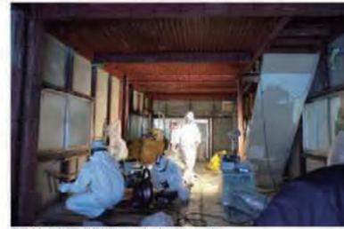
解体は困難な工事となった。古い鉄骨造の建物は毒性の強いアスベストが吹き付けられており、内部の壁天井全てを解体することとなった。
