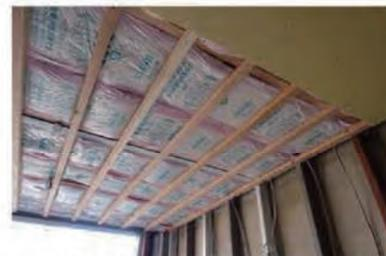
ほとんど断熱材の入っていなかった壁と天井、床下には高性能グラスウール断熱材を充填し、サッシを断熱二重窓に変更することで住環境の性能向上を図った。
