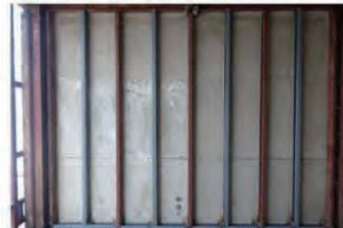
間柱は間隔が大きく空いていたため耐震性能が劣っており、新たに間柱を増設した。腐食した部分は新たに交換し、構造用面材を用いて耐震補強とした。
