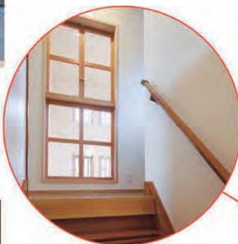
取り込んだ光が階段まで届き、昼に照明をつけなくても安全に上下階の移動ができるよう、吹き抜け上部に小窓を設けた。
