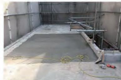
増築されていた3階部分は解体撤去し、屋根の補修と防水を行った。屋上へ上がるベントハウス（PH）は3階部分の増築の際に壊されていたため、新たに組みなおした。解体によって建物重量が軽くなり、また建物の重心が下がるため耐震性能を大幅に向上させた。
