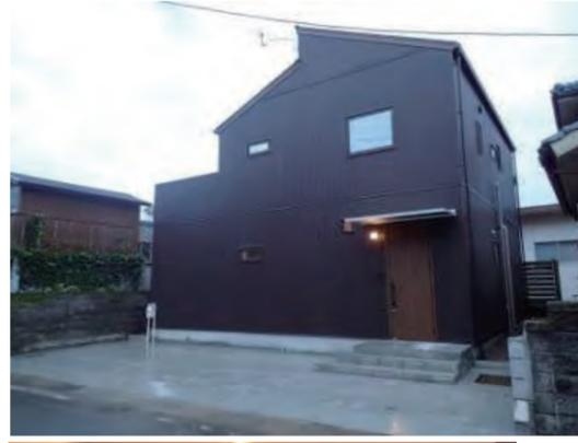
←屋根の改修と一部撤去。外壁金属サイディング貼りとし建物の軽量化を図りスッキリとした佇まいに。
