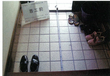
③ 玄関内の玄関扉と 上り框の段差 (220mm)
