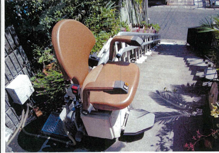
① 椅子式階段昇降機の設置
