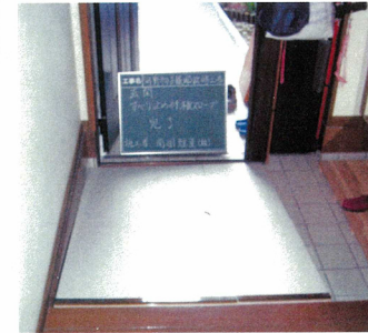
③ 玄関内取り外し式のスロープの設置
