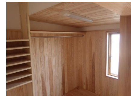
▲増築したクローゼットは板張りでいい香り
