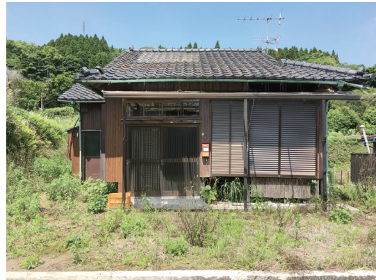
■外観(リフォーム前) 構造体残して内外装材をすべて撤去。取り外したアルミサッシや構造材は再利用して工事費を压さえた計画。
