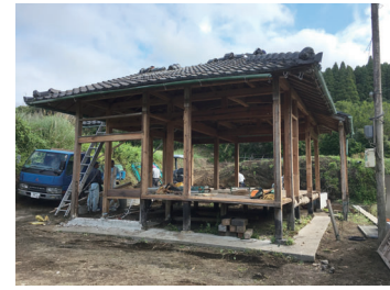
■外観(リフォーム前) 構造体残して内外装材をすべて撤去。取り外したアルミサッシや構造材は再利用して工事費を压さえた計画。
