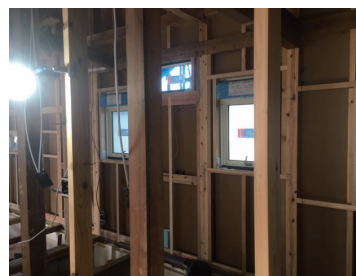
外壁面に耐力面材を設置。
