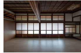
和室の襖を外し床を畳からフローリングへ
