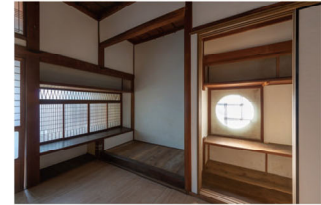
和室の畳下の木材を用いて間仕切り壁に使うことで収納やコンセント等の設置、床と外壁に面する内装の壁面に断熱材設置
