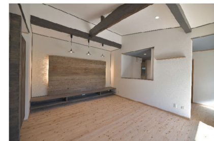
⑤LDKは既存の梁を見せ、勾配天井へ。TVカウンター壁には足場板と間接照明を設置。
