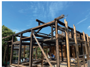
■解体後の外観
