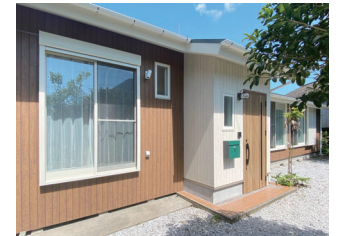
■サイディング張りの外観
