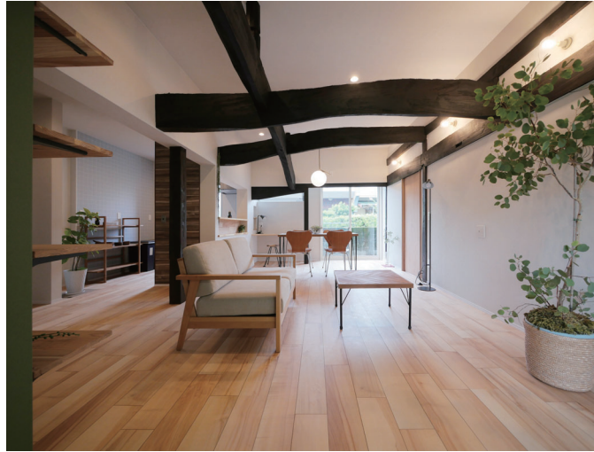
■柱・梁を現しとした古民家リノベーション
