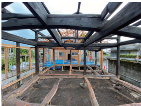
■解体後の室内
