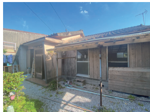
■改修前の外観
