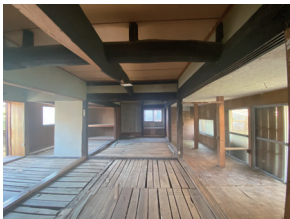
■改修前の室内
