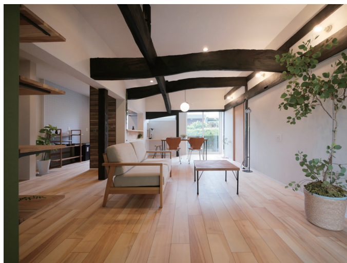
■柱・梁を現しとした古民家リノベーション
