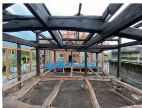
■解体後の室内
