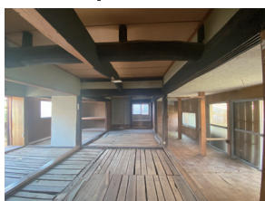
■改修前の室内
