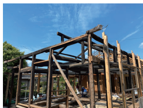
■解体後の外観
