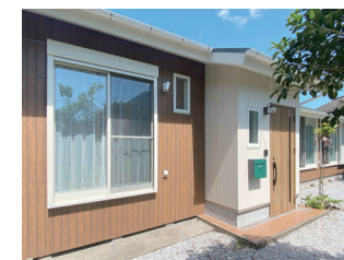
■サイディング張りの外観
