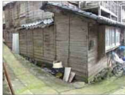
外壁が裸木造の例
