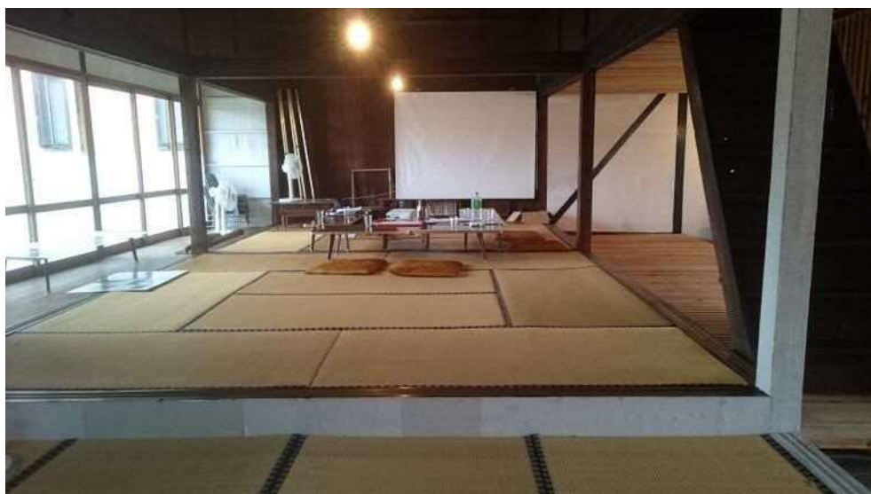
内観・筋交による耐震補強、床板貼は学生が作業
