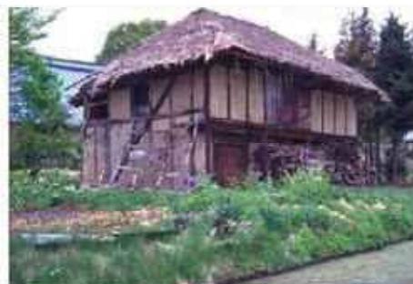
屋根材がワラの例
