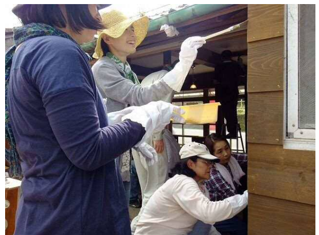
簡易改修(外壁塗装)状況
