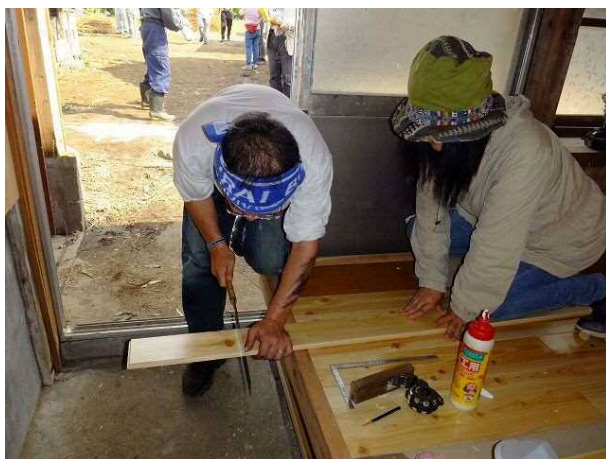
簡易改修(床板張り)状況
