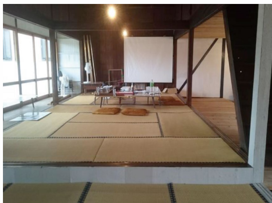
▲内観、筋交による耐震補強、床板貼は学生が作業
