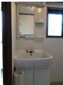
経年劣化が進み、傷みや黄ばみが見られる
