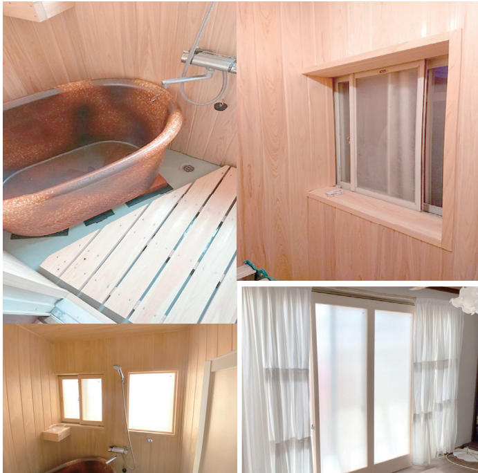
① 改修後浴室
