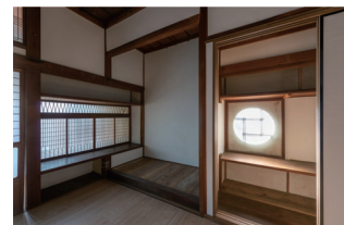
和室の畳下の木材を用いて間仕切り壁に使うことで収納やコンセント等の設置、床と外壁に面する内装の壁面に断熱材設置
