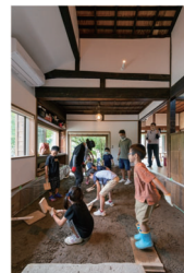
和室の畳下の木材を用いて間仕切り壁に使うことで収納やコンセント等の設置、床と外壁に面する内装の壁面に断熱材設置
