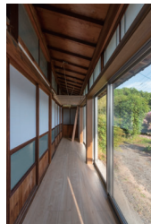
和室の畳下の木材を用いて間仕切り壁に使うことで収納やコンセント等の設置、床と外壁に面する内装の壁面に断熱材設置
