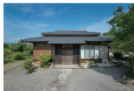
瓦・外壁の修繕、外壁は透水シート・木板（下見板）の設置
