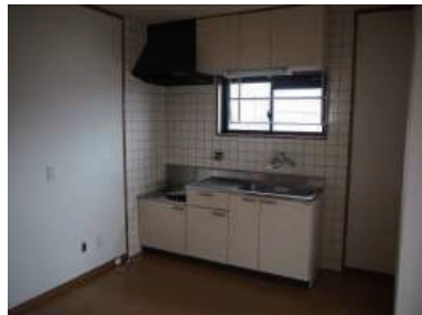
経年劣化による傷みが見られ、冷蔵庫スペースは広さに制限あり
