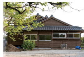
瓦・外壁の修繕、外壁は透水シート・木板（下見板）の設置
