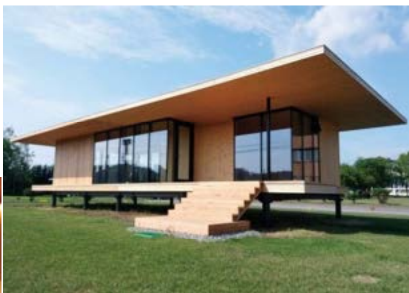
北海道林産試験場CLT性能評価実験棟
