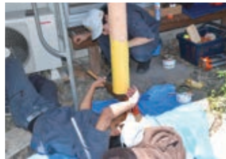
民間住宅土庇の支柱補修工事
