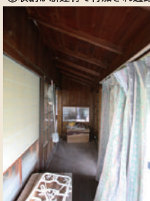
④物置となっている北側縁側
