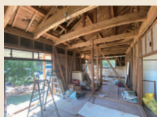
解体状況(内観)
