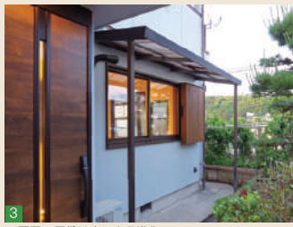
3 ▲玄関クロークを新設した玄関
