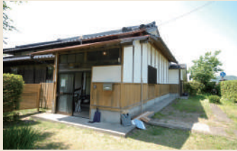
外観施工前③
