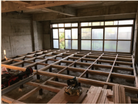
③内部解体後施工状況 根太高さ調整
