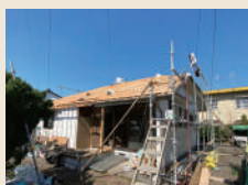
解体状況(外観)
