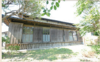
外観施工前②
