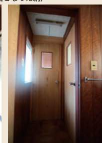
⑤新材で覆われた増築部分
