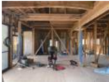
⑤工事途中(耐震補強)
