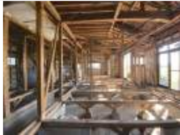
④工事途中(解体後)
