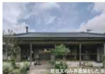
屋根瓦のみ再塗装をした ※
