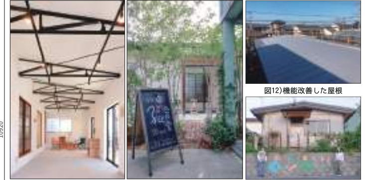
図10) 改修後のレンタルスペース 図11) 新設した隣地からの小道 図13) 改修後のファサード
