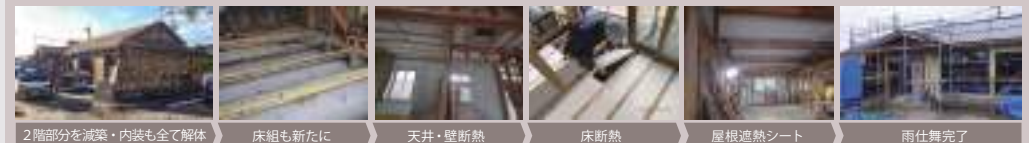
2階部分を減築・内装も全て解体
