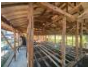
■解体撤去状況
