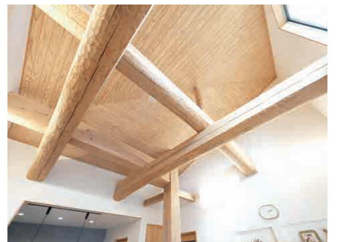
一本約 500 kg の地元産無垢材を井形に四本組み上げた太鼓梁。住まいの主役として空間を支え、時折響く「パキッ」という音が木の生命力を語っています
