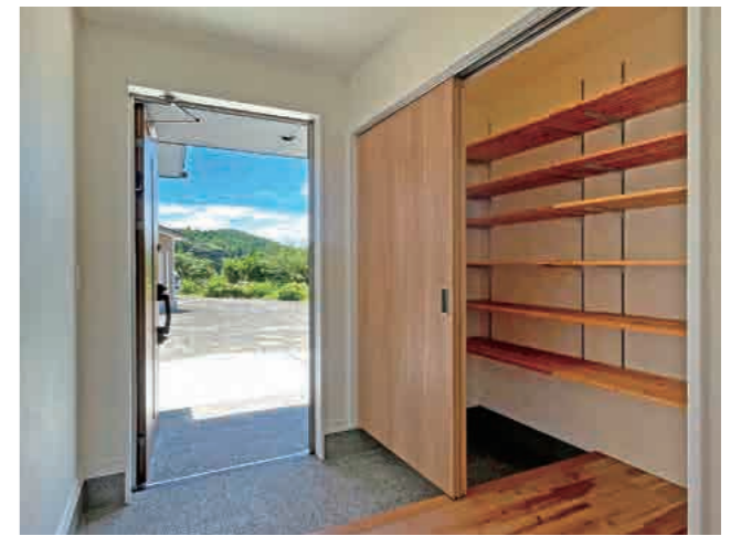
自然の風合いをいかした洗い出し仕上げの玄関土間は、木の家とも相性抜群。シューズクロークの杉棚板は可動棚にすることで、効果的に収納できます
