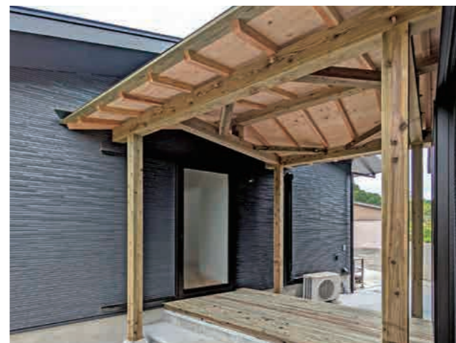
既存の別棟書斎への渡り廊下。構造材現しにすることで、木の素材感や力強さをダイレクトに感じさせる
