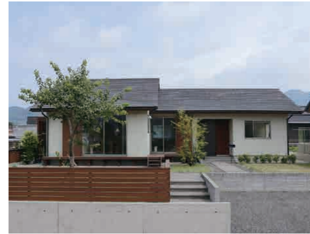
深い軒と植栽（シンボルツリーのヒメシャラ）計画により日差しを制御し、夏は木陰をつくり冬は光を招く、季節に寄り添う住まいを構築しています
