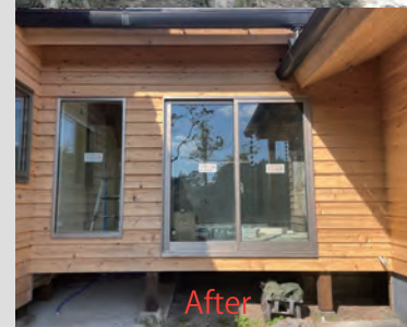
5㎡増築し、厩（左側）と母屋（右側）をつなげ、ひとつの建物に。
