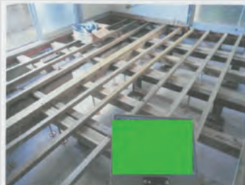
シェルターを設置するための床組補強
