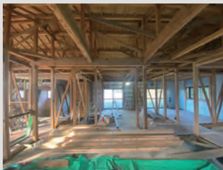
■解体撤去状況
