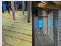
床下と壁に断熱材を施工した様子。既存は無断熱だったため大幅に断熱向上した。
