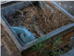
使われなくなった囲炉裏。きちんと手をいれて、再生。床材でも造作した。
