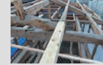
屋根の構造材の取替・補強の様子。新旧の材が繋がる様子は趣深い。
