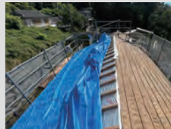
天井現しのため既存の屋根の上に重ねて、新しい屋根をつくっているところ。
