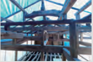
解体工事がほとんど終わつ段階。古民家ならではの立派な構造材が露わに。
