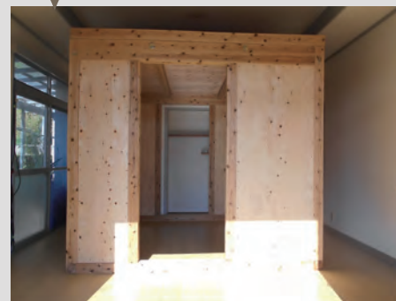
命を守る耐震シェルター完成
