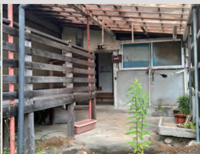
③ 既存写真：玄関と解体した増築部分
