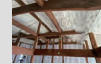
屋根断熱が完了した段階。元々の無断熱から大幅に断熱性能が向上した。
